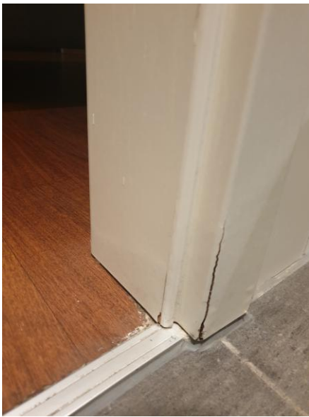
Schadensbilder aus der Praxis: Aufquellungen und Verformungen im unteren Bereich von Standardzargen. Fotos: M. Müller
