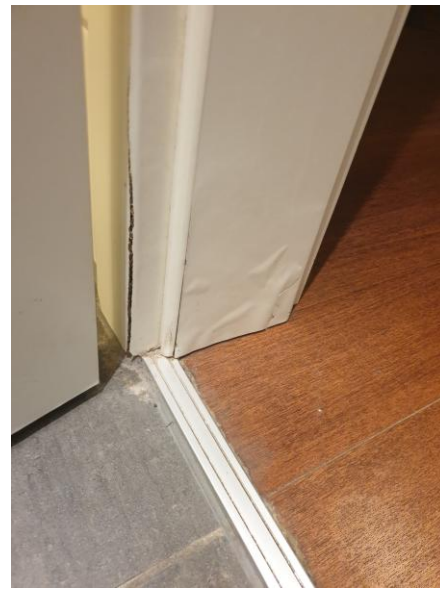
Schadensbilder aus der Praxis: Aufquellungen und Verformungen im unteren Bereich von Standardzargen. Fotos: M. Müller
